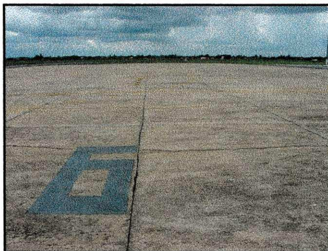
Figura 3.10 – Registro fotográfico digital de uma seção do pavimento para a avaliação das condições de superfície – Pátio.
