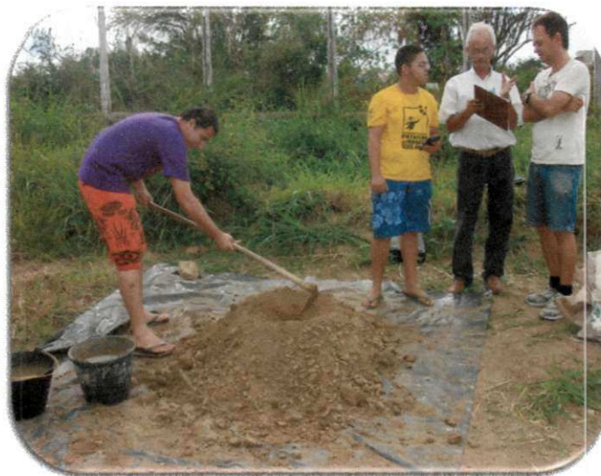
Figura 20 - Mistura de água e solo para execução das camadas
