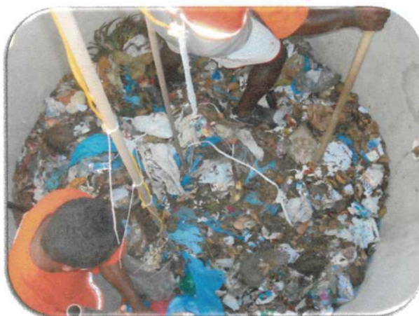
Figura 40 - Compactação dos resíduos
