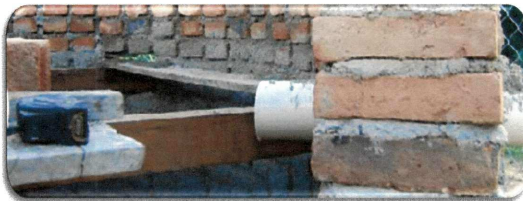
Figura 16 - Foto da construção do lisímetro
