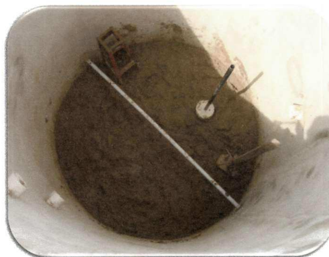
Figura 21 - Execução da camada de base
