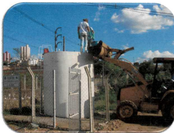
Figura 39 - Lançamento dos resíduos na célula
