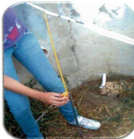
Figura 49 - Leitura das Placas de Recalques Superficiais
