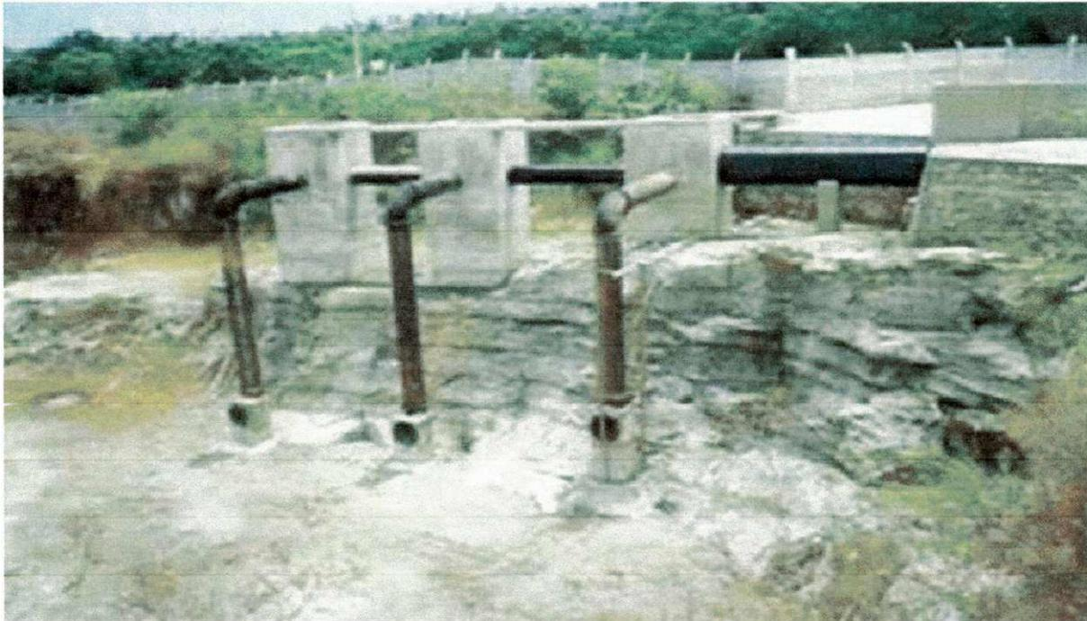
**Figura 3.5** - Dispositivo de entrada da lagoa anaeróbia antes do início do funcionamento.
