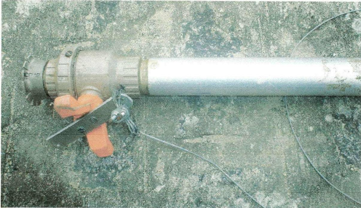
**Figura 3.15** - Dispositivo de entrada do coletor de lodo.
