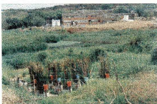
(a) Wetland construído ao lado da lagoa, após 12 meses de funcionamento
