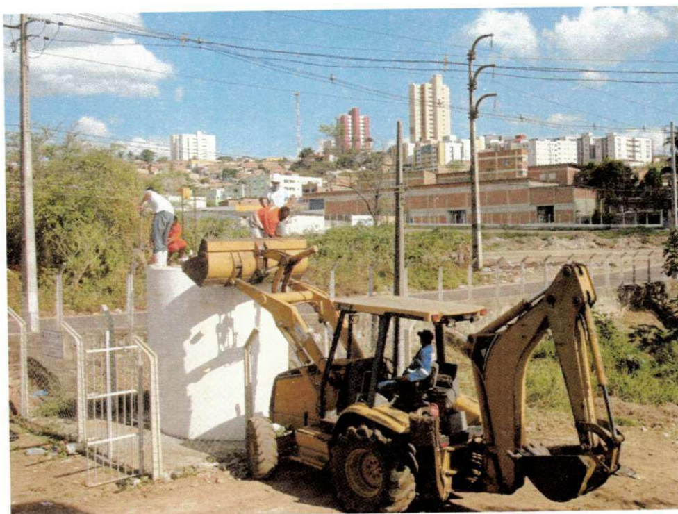
Figura 17 – Resíduo sendo depositado na célula experimental.
