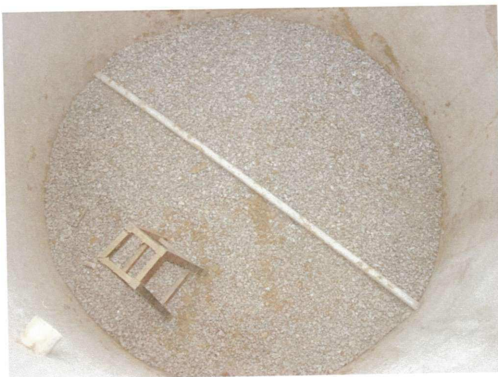
Figura 16 – Camada de base da célula experimental.
