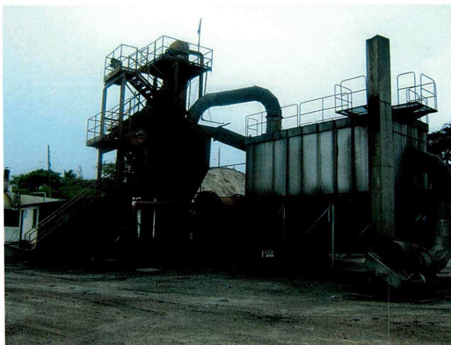
Figura 3.9 – Foto da usina de Concreto Asfáltico Usinado a Quente (CAUQ) da EMURB.
