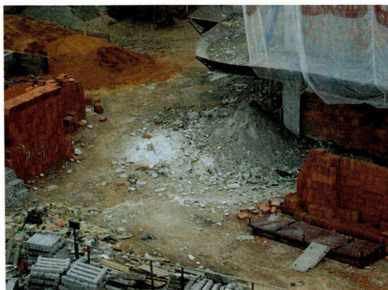
Figura 2.3 – Resíduos de gesso misturados a outros materiais em uma construção de edifício residencial em Aracaju (2009).
