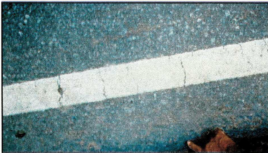
Figura B2* : Foto de um trecho experimental (1997) com asfalto polímero (SBS) em mistura tipo CBUQ, na rodovia PE-74 de base estabilizada solo-cimento, realizado em 1994.
