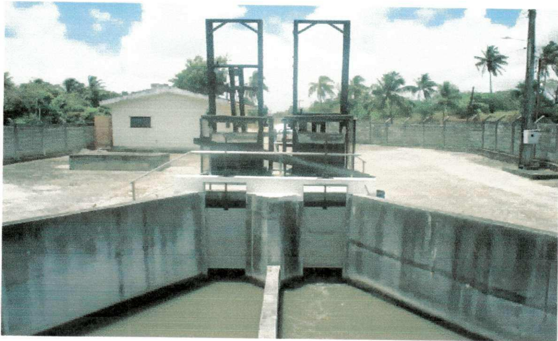
Figura 3.6 - Grade mecanizada e caixa de areia.
