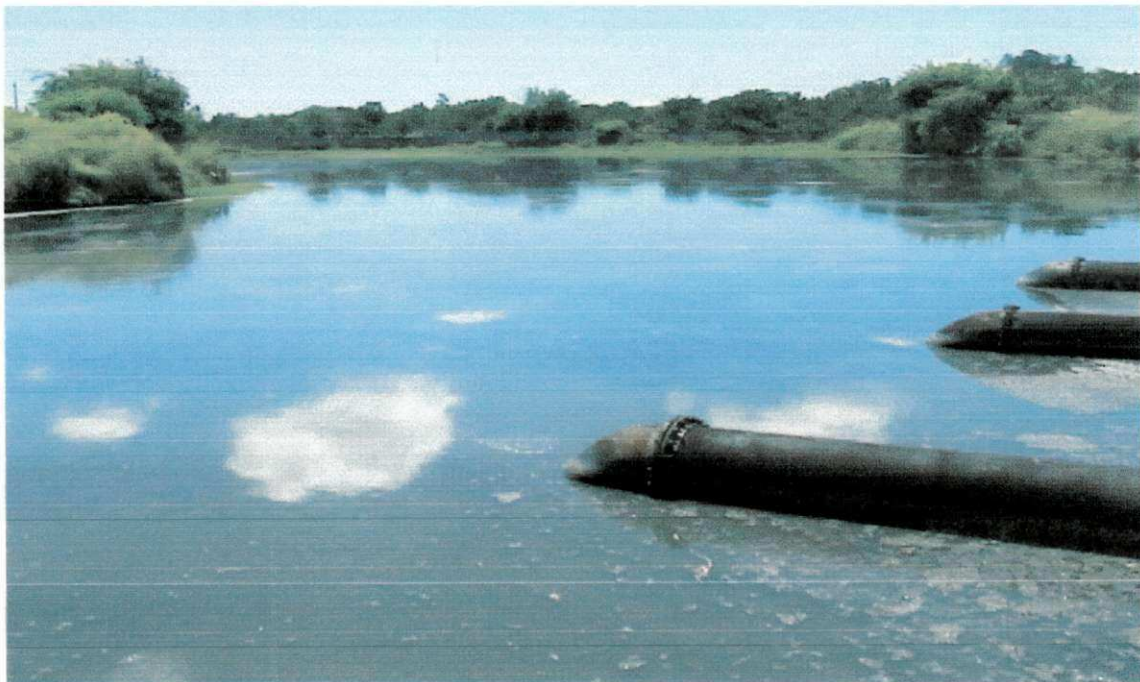
Figura 3.4 – Vista geral da entrada da lagoa anaeróbia.
