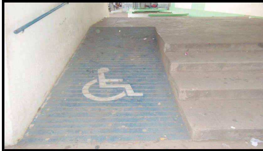
Imagem 6: Rampa e Escada
