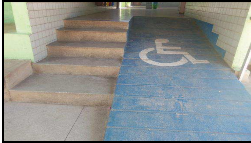
Imagem 2: Escada e Rampa
