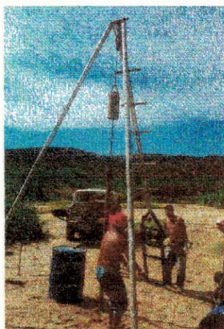
Figura 16 : Vista frontal de uma perfuração (sondagem) com circulação de água com trado manual
