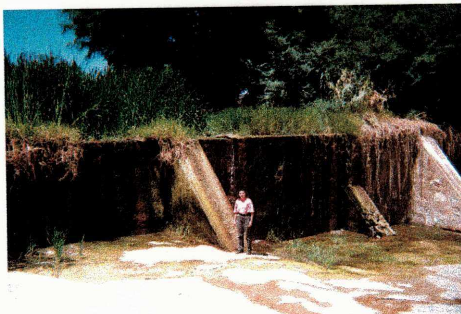
Figura 15 : Barragem de aluvionamento B 1 na saída do aquífero em estudo em agosto/96.
