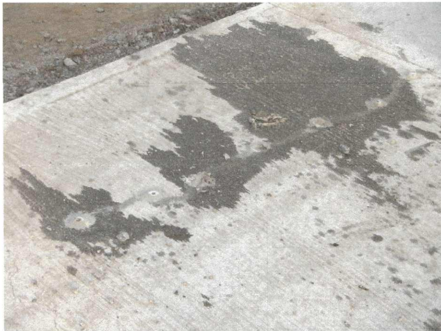
Figura 2.12 - Resultado da aplicação da resina epoxídica.
