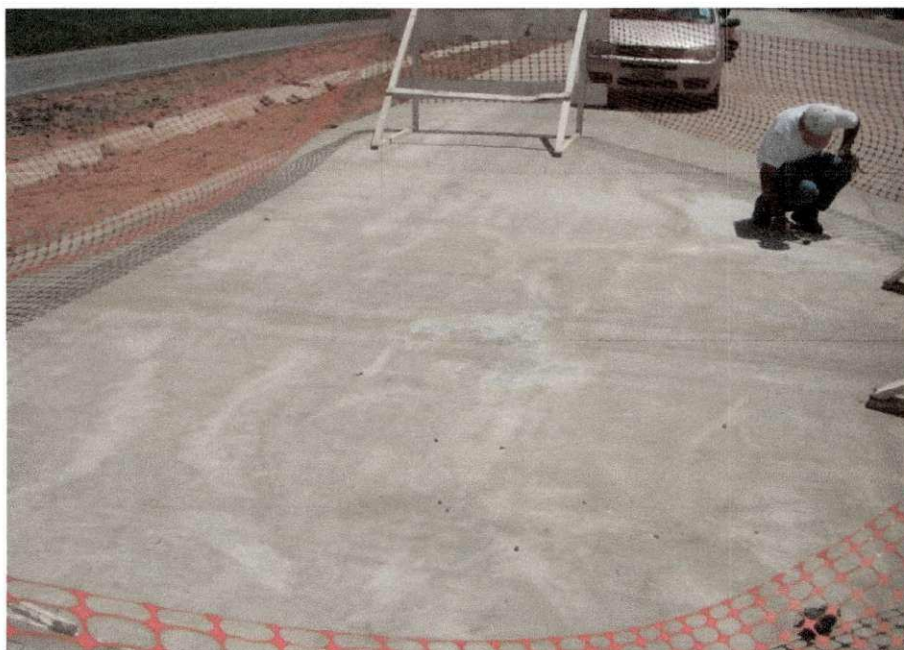
Figura 2.19 - Isolamento da área.
