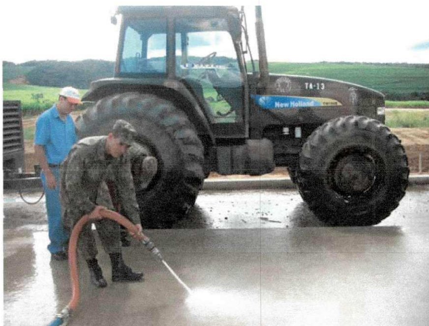
Figura 2.20 - Lavagem do pavimento e das fissuras com água pressurizada visando a desobstrução das fissuras por partículas sólidas.
