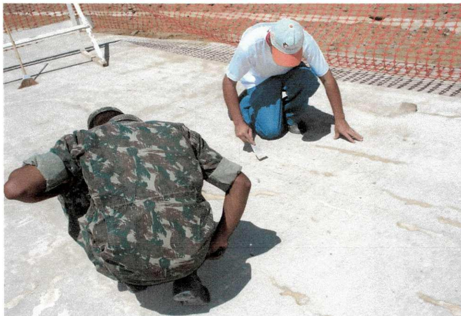
Figura 2.24 – Remoção e limpeza do excesso de calda coloidal sobre a fissura.
