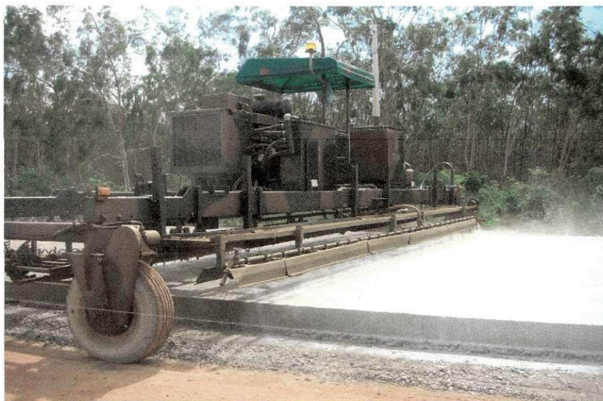
Figura 2.11 - Execução da cura química
