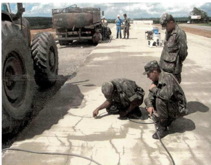
Figura 2.21 - Secagem e expulsão da água sobre as placas e no interior das fissuras por aplicação de ar comprimido seguido de evaporação natural.
