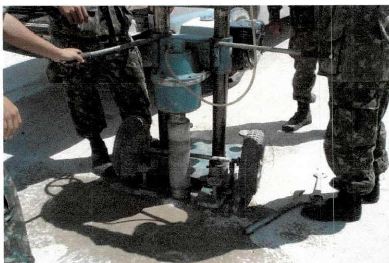
Figura 3.2 – Equipamento de extração dos corpos de prova.
