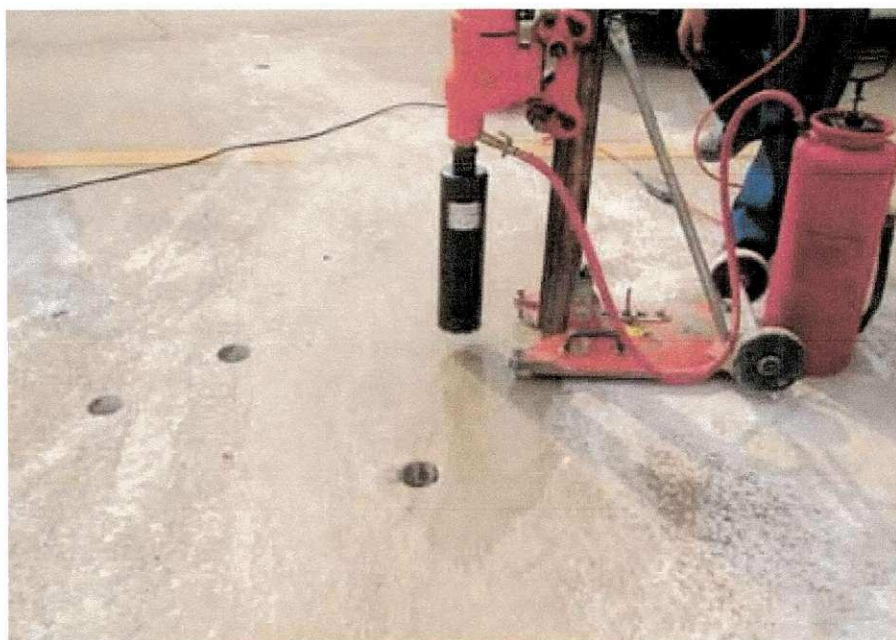
Figura 2.9 – Extração de corpo de prova após injeção sobre fissura. Fonte: Abreu, (2005).
