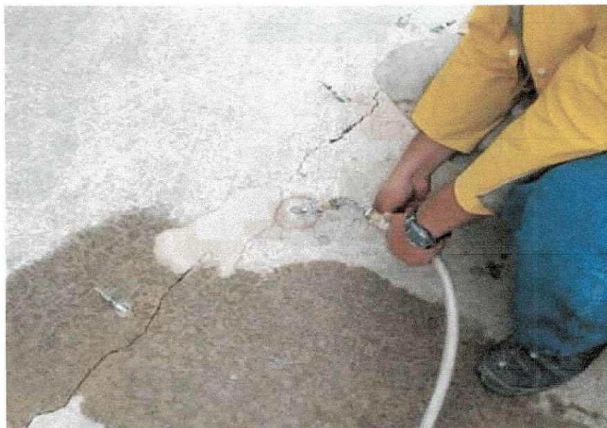
Figura 2.8 – Injeção de microcimento na fissura do pavimento. Fonte: Abreu, (2005).
