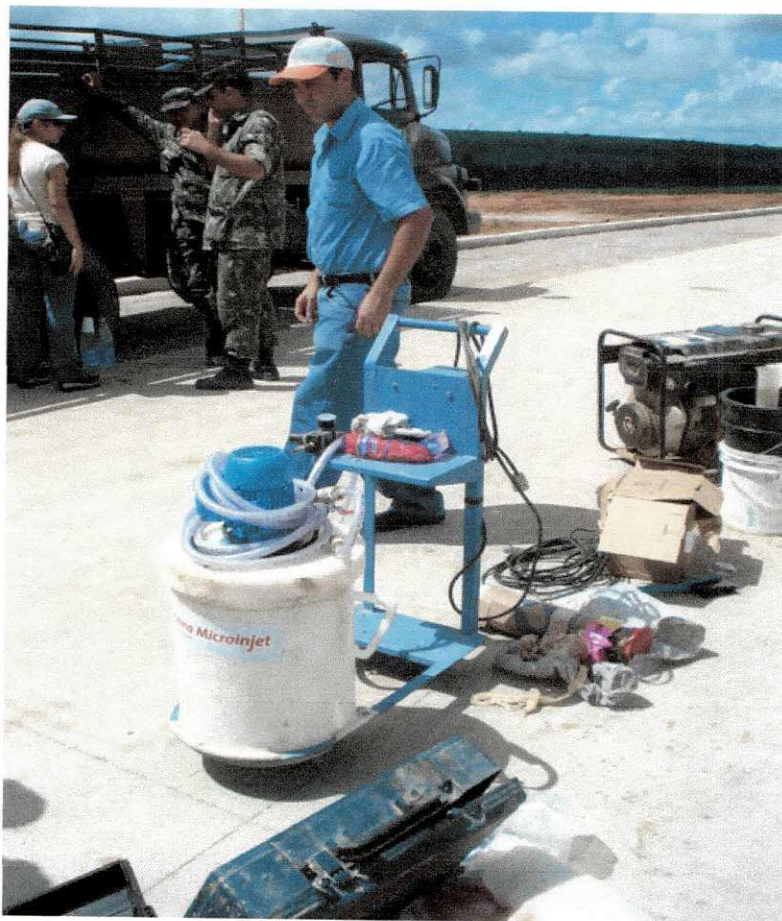
Figura 2.22 - Preparo da calda coloidal de microcimento com o emprego do misturador coloidal.
