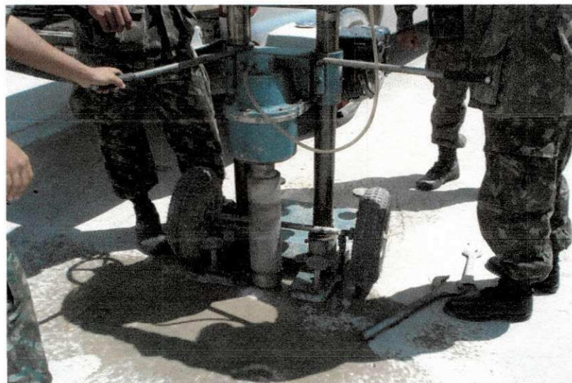
Figura 2.28 – Extratora para retirada dos testemunhos.
