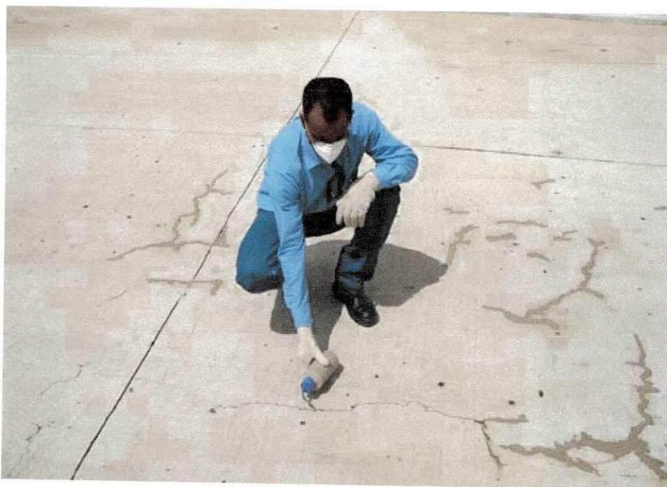
Figura 2.23 – Preenchimento das fissuras através da injeção por gravidade (Picetes) utilizando calda coloidal de microcimento.
