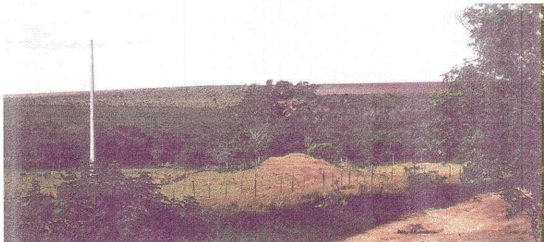
Figura 5 – Vista frontal da boçoroca, com posição do antigo leito da rodovia BR 163.
