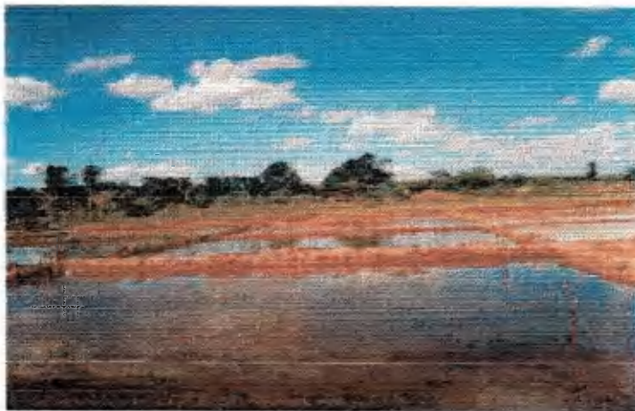
Figura 3. Diques para contenção de água
