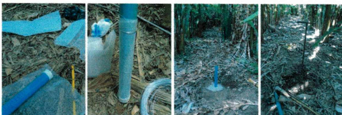
Figura 7: Instalação e material dos poços
