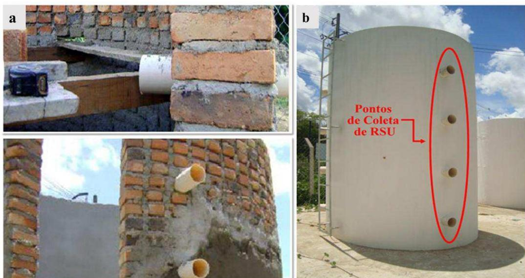
Figura 6 - Célula experimental de RSU: a) Em construção; b) Construída com destaque para os pontos de coleta
