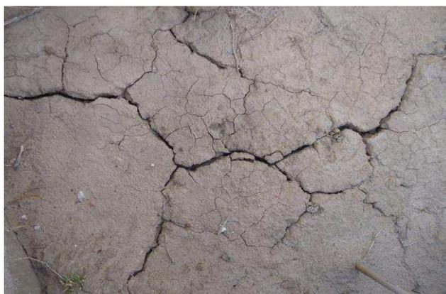
Figura 36 – Fissuras e trincas presentes no solo da camada de cobertura da célula experimental
