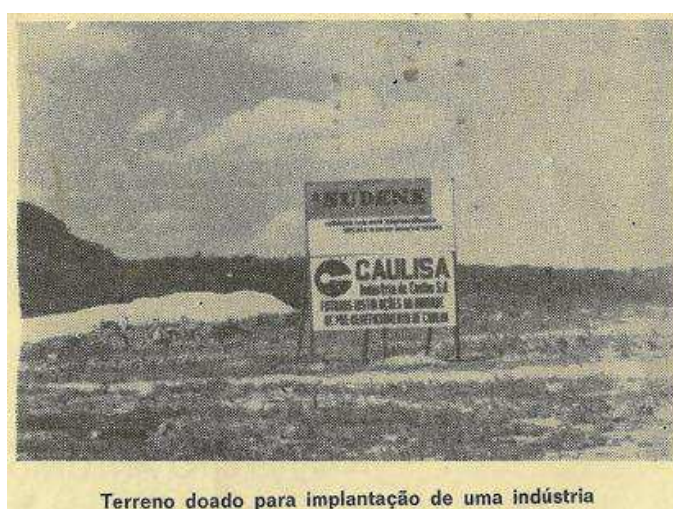
Foto 12 – Placa indicando obras de instalação da Caulisa em Junco do Seridó
