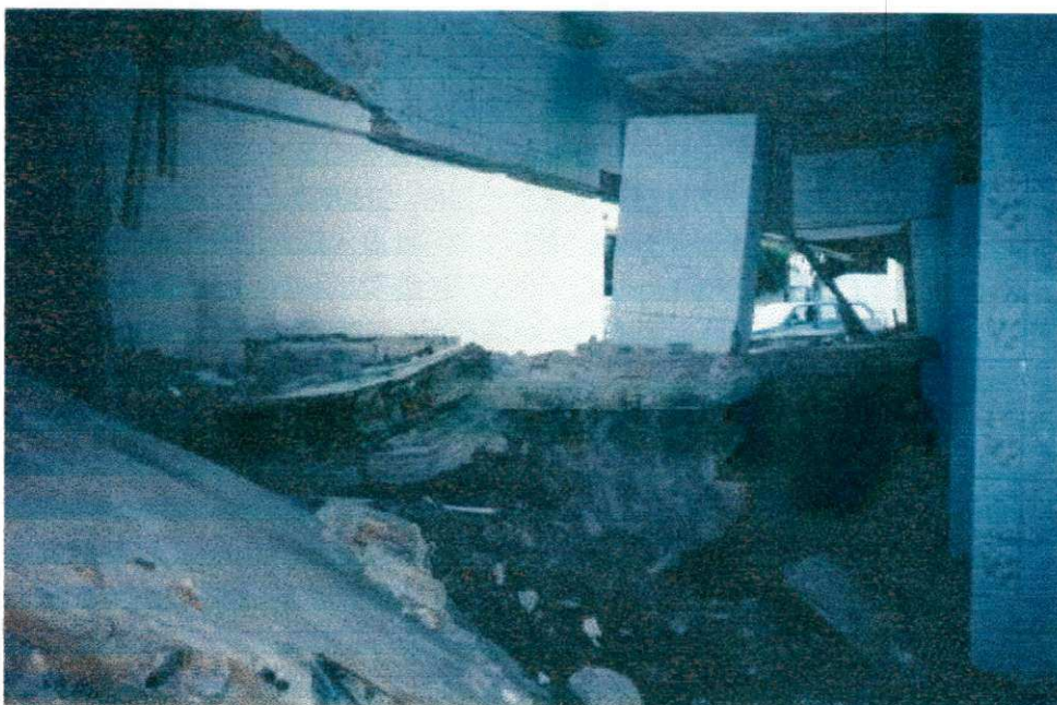
Foto 2 – Face interna com visão para o lado Norte
