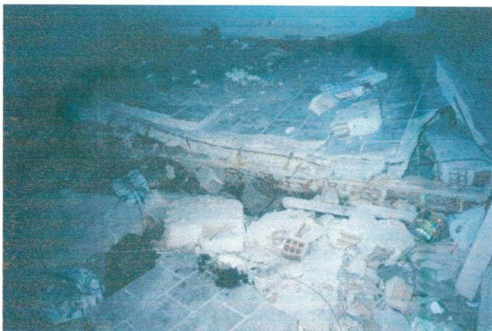
Foto 3 – Laje do piso
