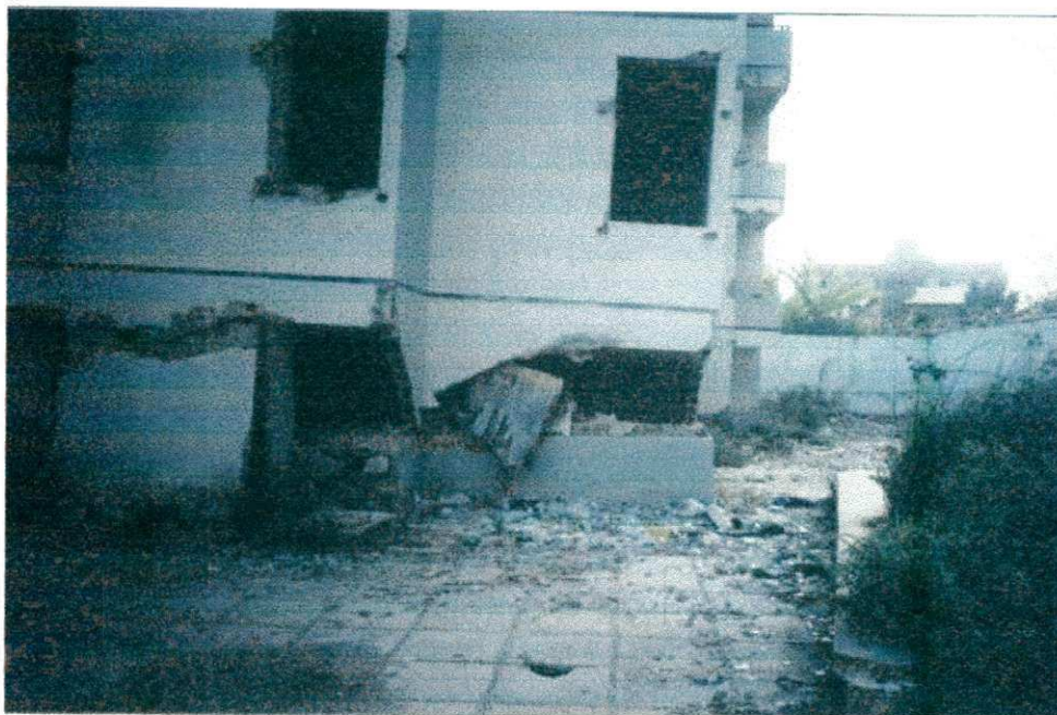
Foto 1 - Face leste do Edifício Aquarela
