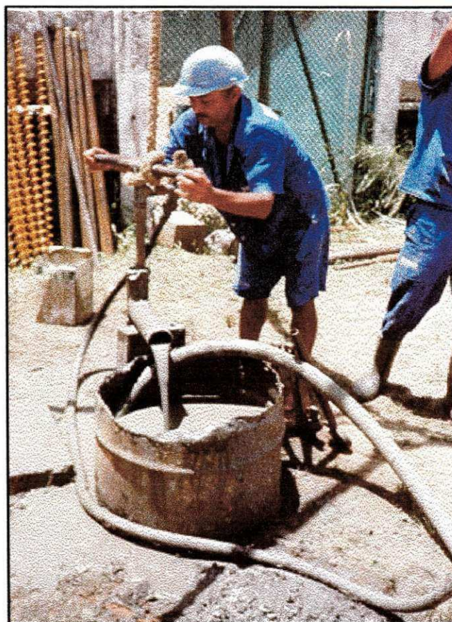
Figura 3.13 - Processo usado na execução dos furos para realização de ensaios pressiométricos.
