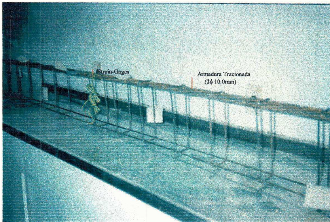
Fotografia 1 - Ferragem das Vigas
