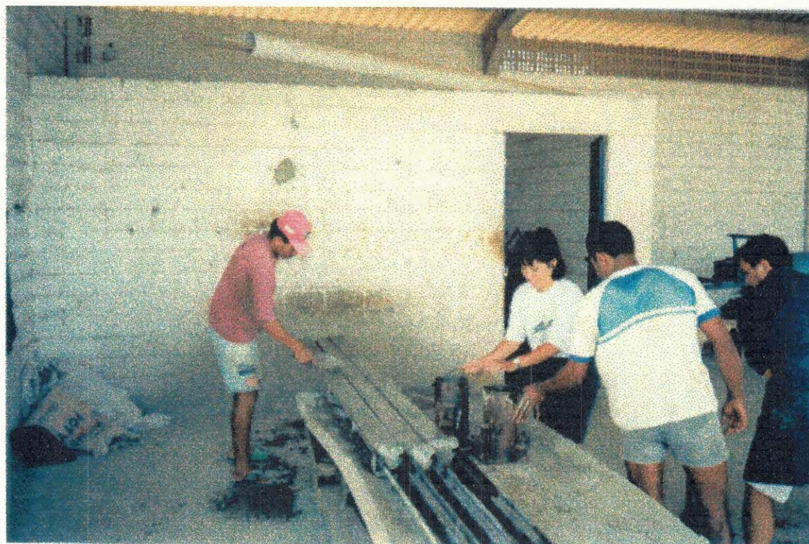
Fotografia 5 - Concretagem das Nervuras das Lajes Pré-moldadas
