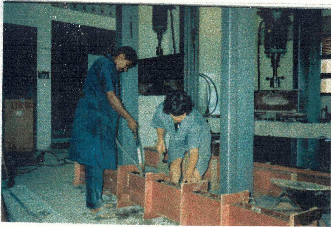
Fotografia 2 - Concretagem das Vigas
