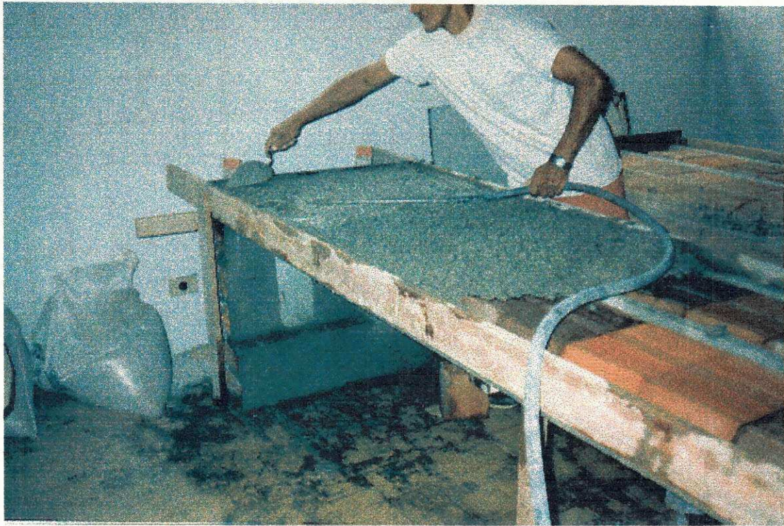
Fotografia 6 - Capeamento das Lajes Pré-Moldadas
