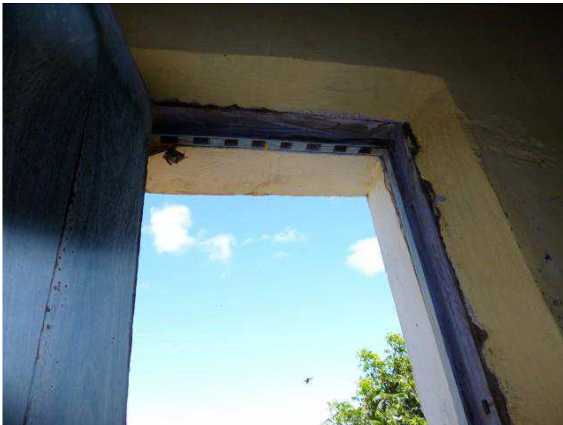
Figura 26: Caixilho (Casa de Sady Wanderley). Foto do autor (2014)
