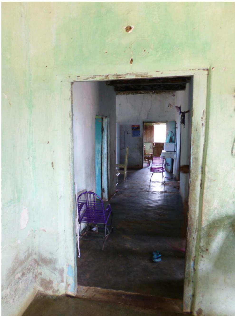
Figura 34: Corredor de circulação da Casa de Chico Bezerra. A presença de caixilho é um resquício de uma porta antigamente existente. Foto do autor (2017).
