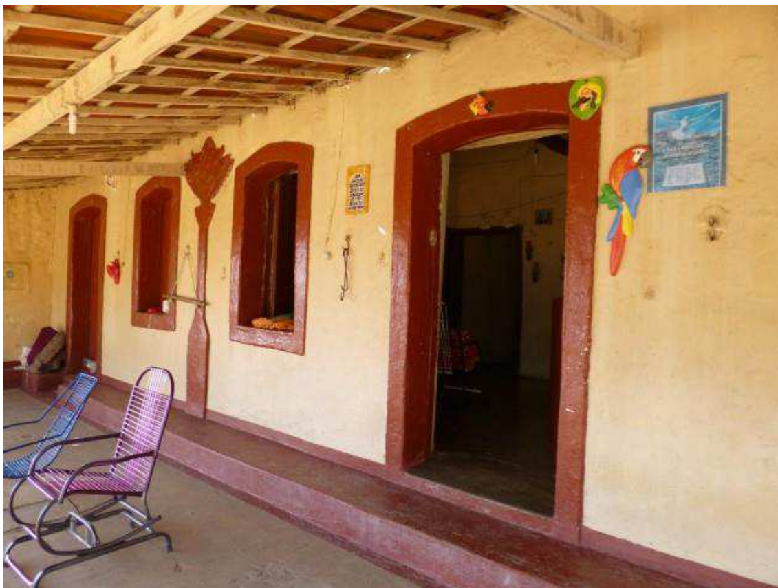
Figura 27: Frisos em alto relevo que emolduram as aberturas frontais da Casa velha . Foto do autor (2017).
