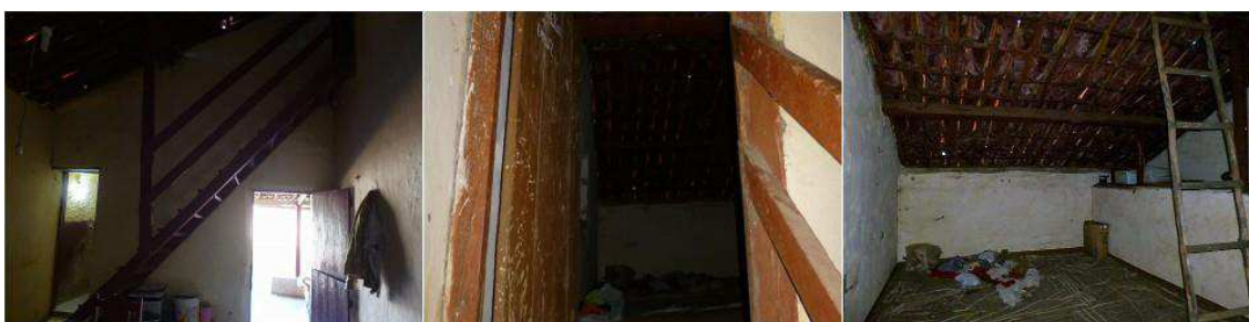
Figura 43: Escada e abertura de acesso e interior do sótão da Casa velha . Fotos do autor (2017).
