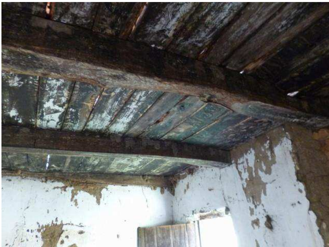
Figura 45: Piso do sótão da casa de João Bezerra. Não pudemos visualizar a parte de cima do piso. Foto do autor (2017).
