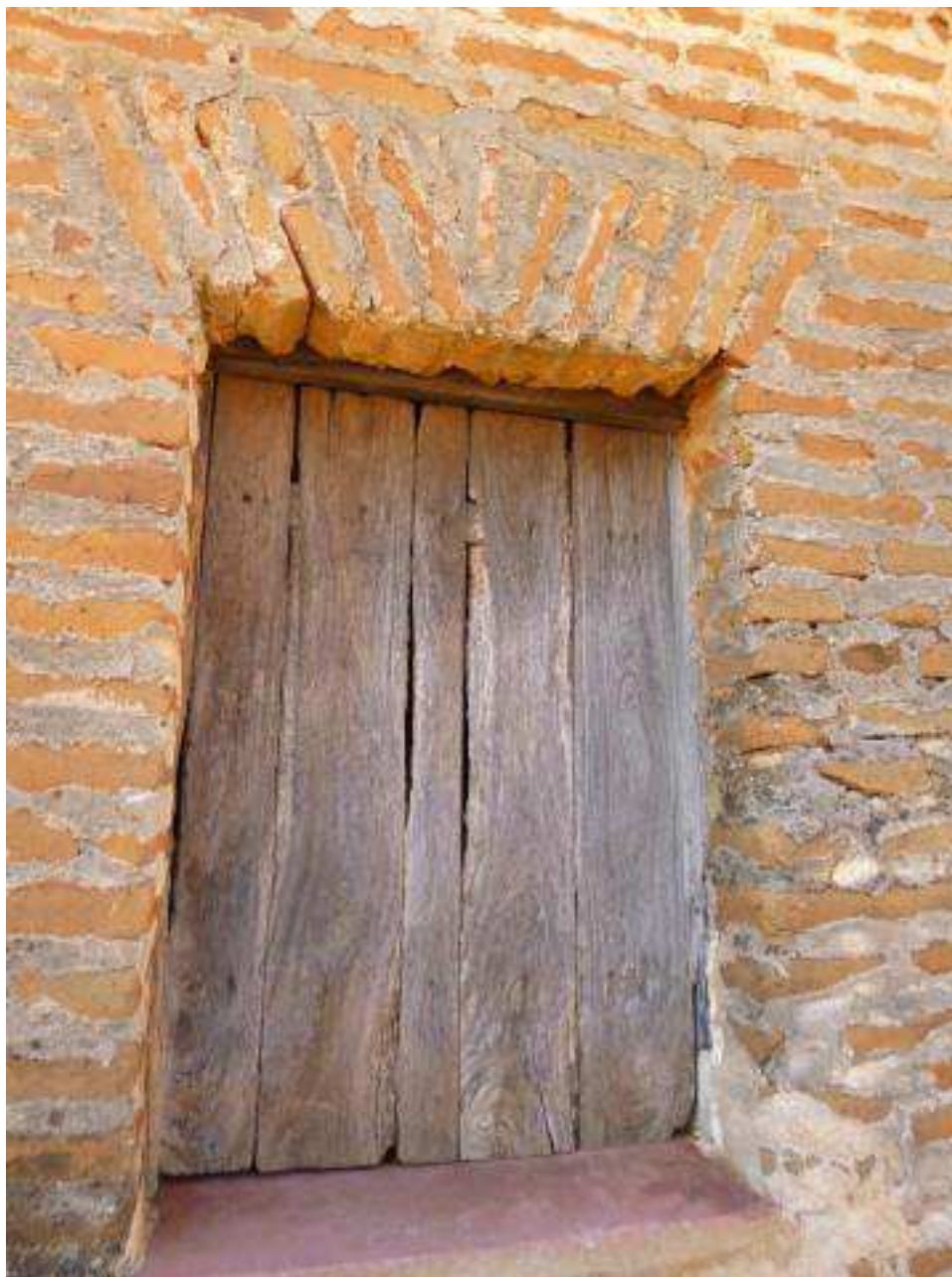
Figura 25: Janela com arco reto na casa de Aquilino Marques. Foto do autor (2017).
