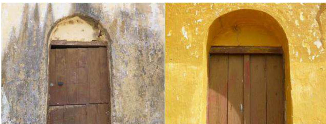
Figura 24: Arco pleno do chalé de Vicente Xavier. Fotos do autor (2017).
