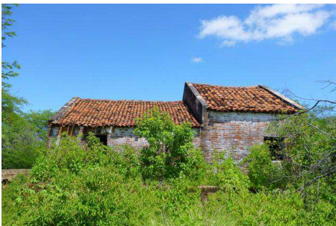
Figura 44: Detalhe da parte elevada da Casa de João Bezerra que abriga o sótão. Foto do autor (2015).
