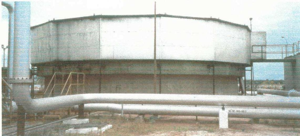
**Figura 1.2** – Tanque para armazenamento de emulsões óleo – água (Fonte: Pólo Industrial de Guamaré (RN) - PETROBRAS®)
