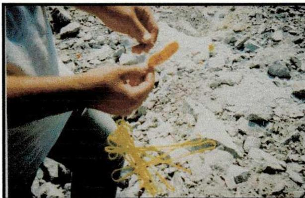
Figura 5.13 - Conexão dos fios na linha tronco (2002).
