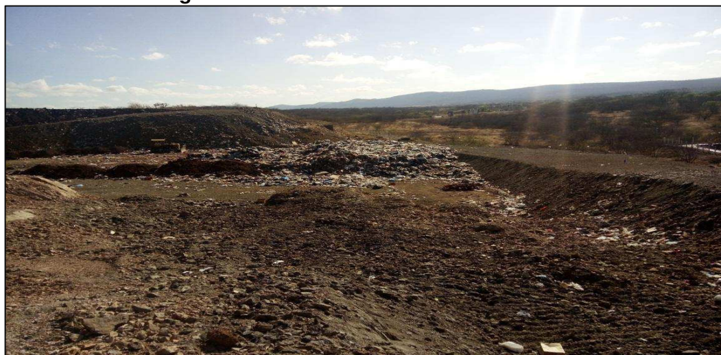
Imagem 03: Aterro sanitário da cidade de Sousa.
