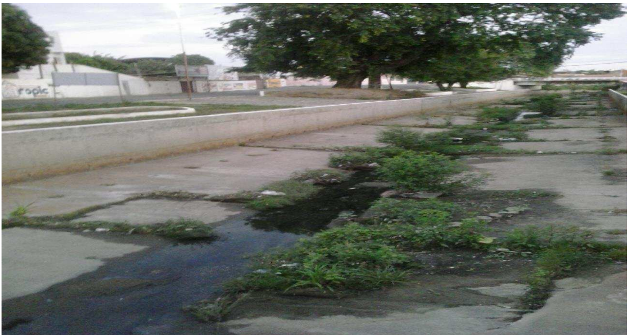
Foto 5 – Antes da limpeza
