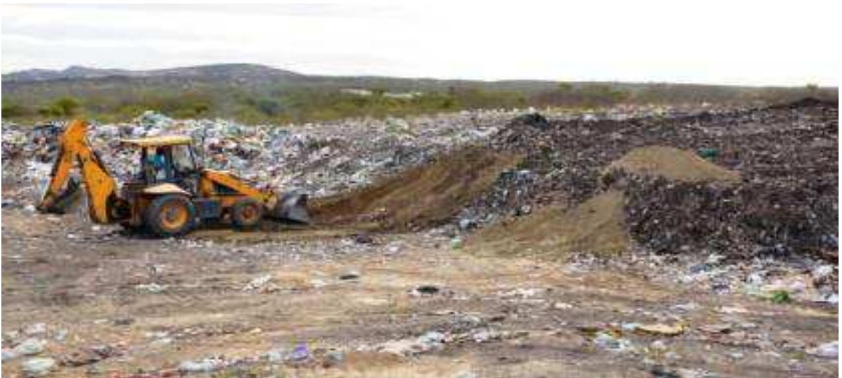
Imagem 5 – Forma irregular de aterramento do “lixo”
