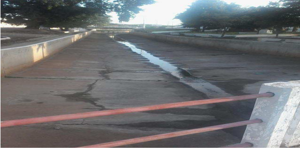
Foto 6 – Depois da limpeza
