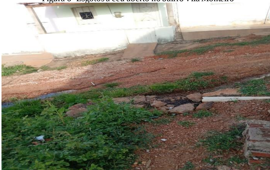
Figura 6- Esgotos a céu aberto no bairro Vila Monteiro
