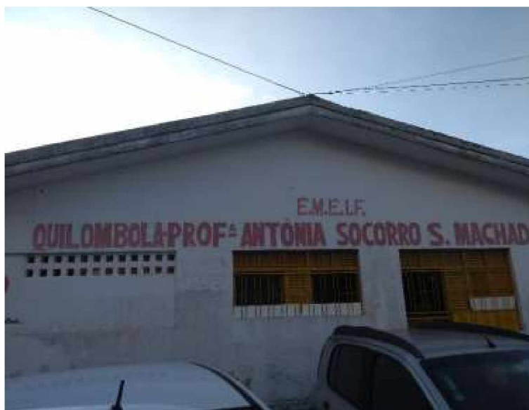
Figura 3 - Parte da frente da Escola Municipal Quilombola Profa. Antônia do Socorro Silva Machado
