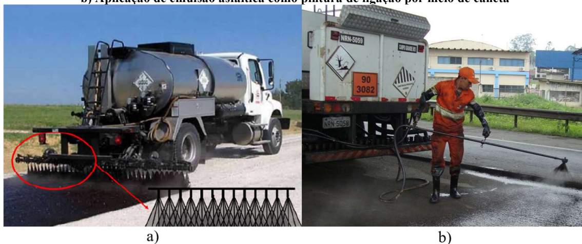
Figura 2.5 - a) Aplicação de emulsão asfáltica como pintura de ligação por meio de barra espargidora e b) Aplicação de emulsão asfáltica como pintura de ligação por meio de caneta
