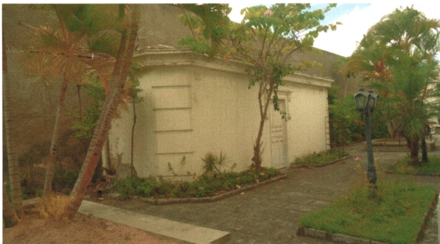
Imagem 15 – Estrutura que serviu de banheiro para o Grupo Escolar Solon de Lucena no jardim localizado ao lado direito do prédio.
