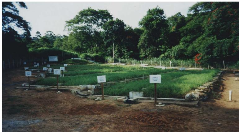
Figura 1. (a) Tratamento preliminar: grade e desarenador; (b) Tratamento secundário: rampas com 2% de declividade.
