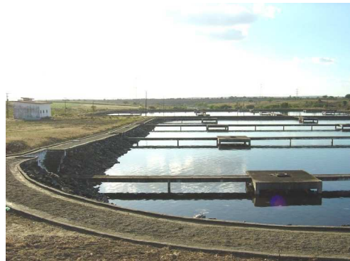
ETE da catingueira – Campina Grande-PB
