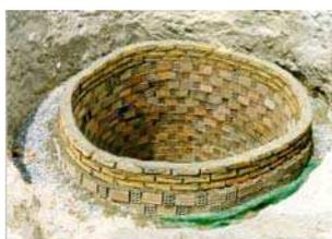
Figura 5 – Poço amazonas construído com tijolos furados na porção inferior e tijolos maciços na parte superior.
