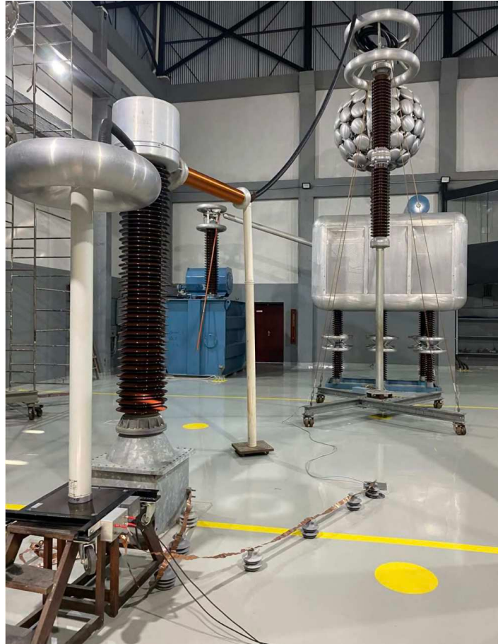
Figura 27 – Vista 2 da montagem do ensaio de descargas parciais
