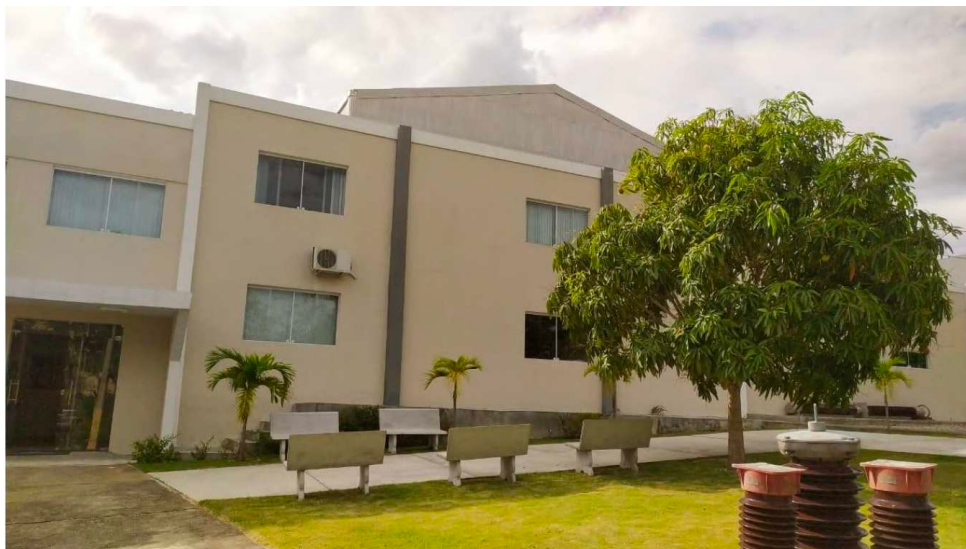
Figura 1 – Entrada principal do LAT
