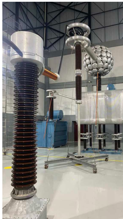
Figura 25 – Montagem do ensaio de tensão suportável à frequência industrial a seco
