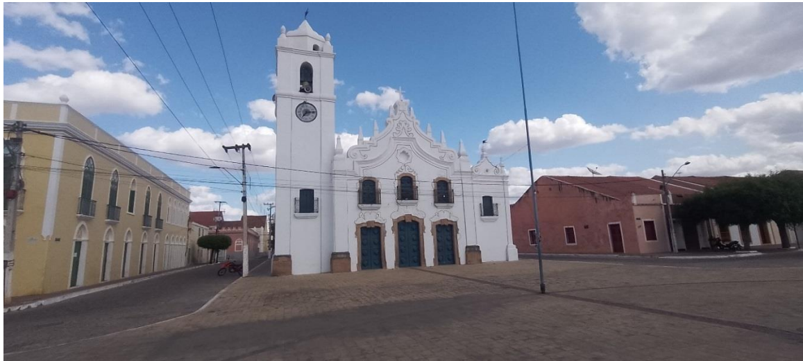
Figura 19- Igreja de Nossa Senhora da Expectação/ Igreja Matriz.
