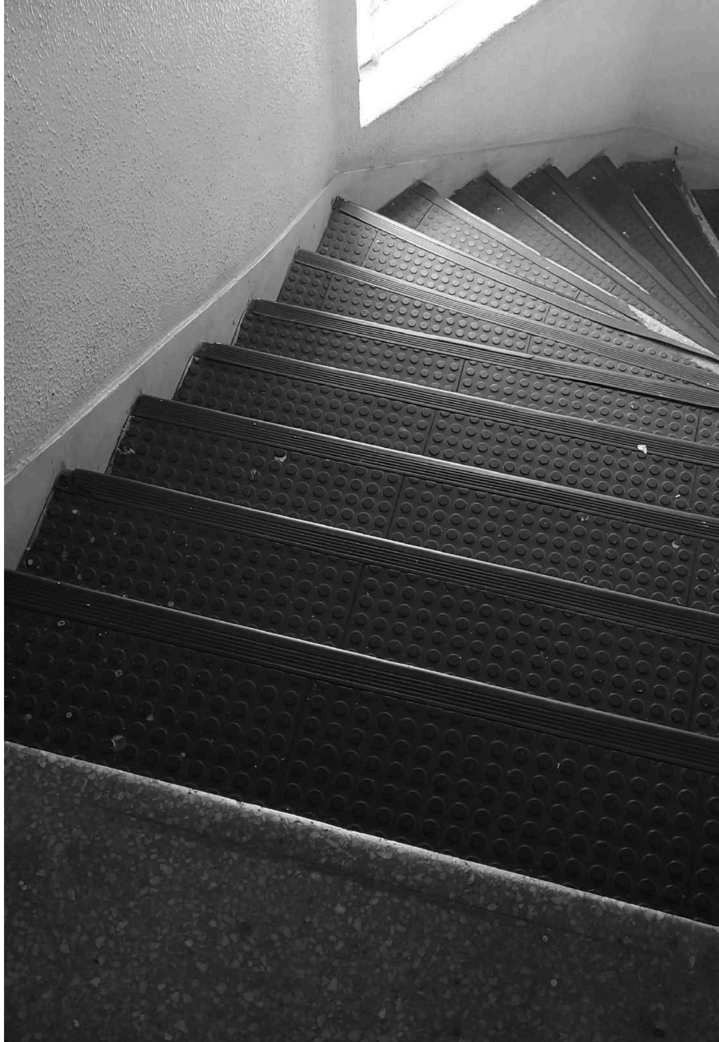
100 Piso emborrachado na escada. Fonte: autor 2024.
