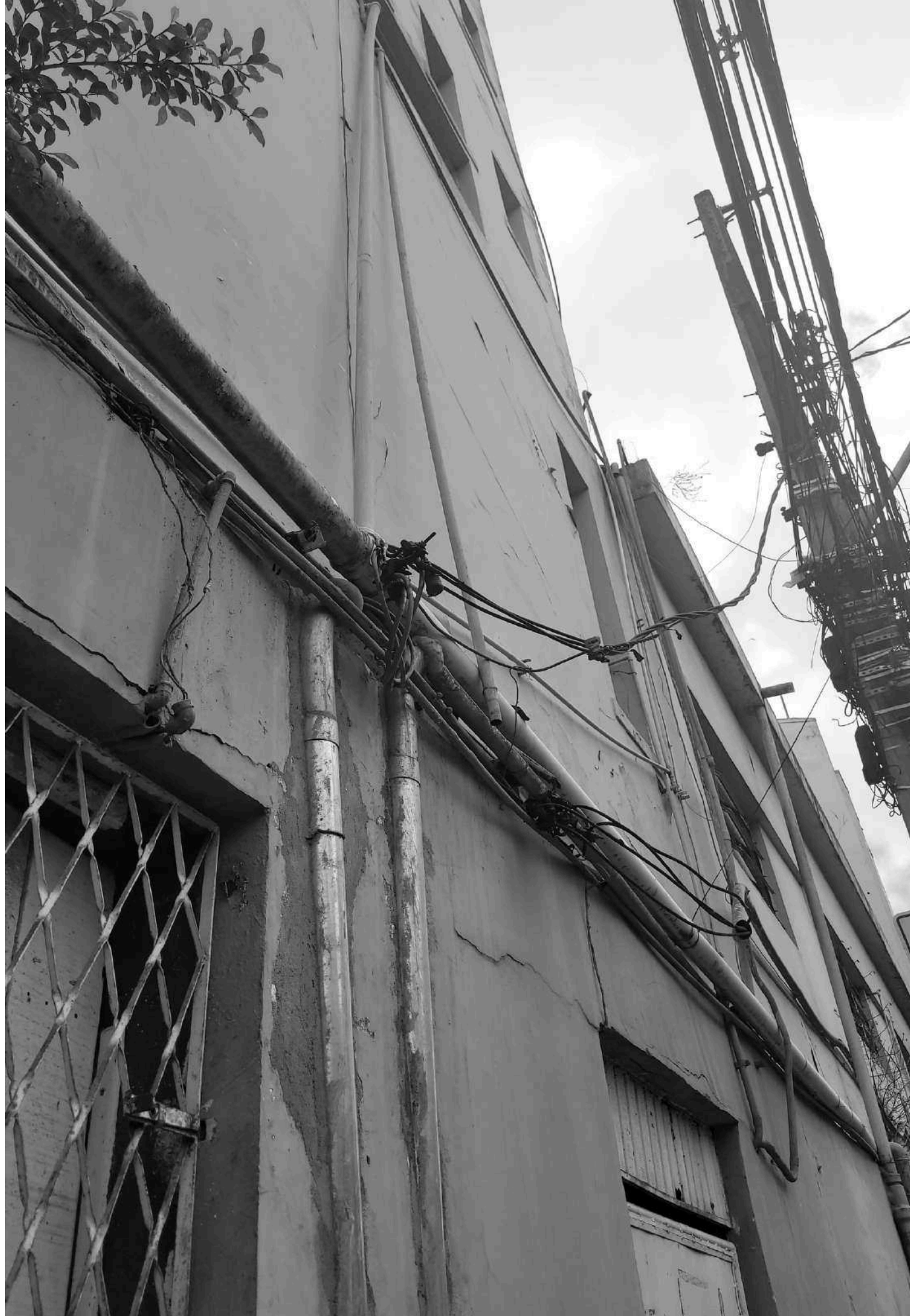
95 Fiação e encanamento na fachada da rua Afonso Campos. Fonte: autor 2024.
