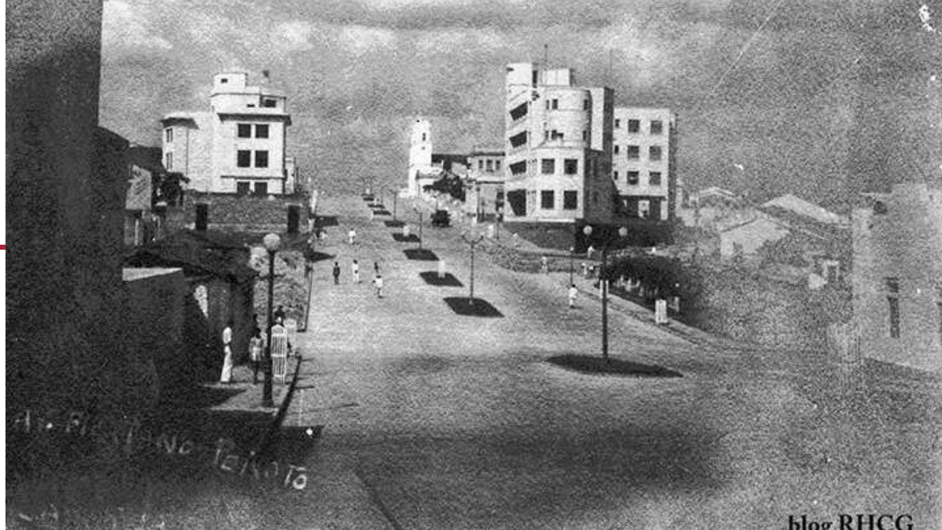
47 Imagem dos edifícios e sua relação com a Avenida Floriano Peixoto, 194?. Fonte: IBGE, 2024.
