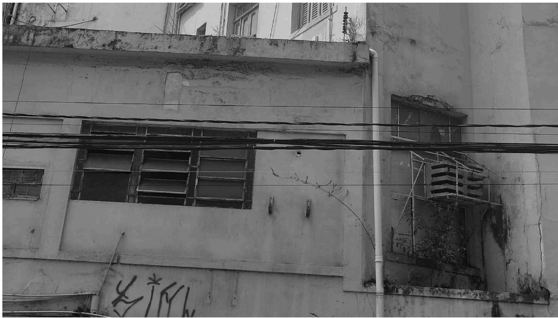
93 94 vegetação crescendo na fachada, bolor e mofo e umidade. Fonte: autor 2024.
