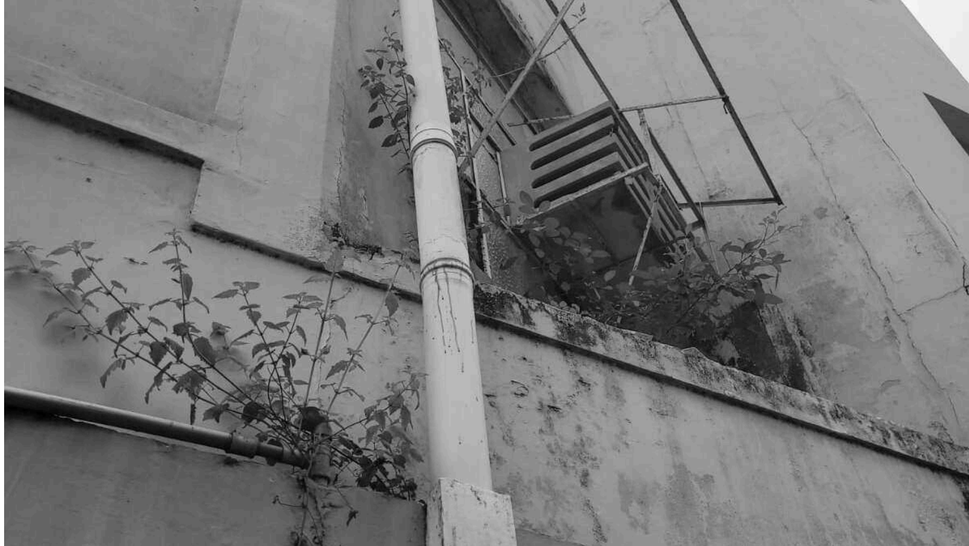
93 94 vegetação crescendo na fachada, bolor e mofo e umidade. Fonte: autor 2024.
