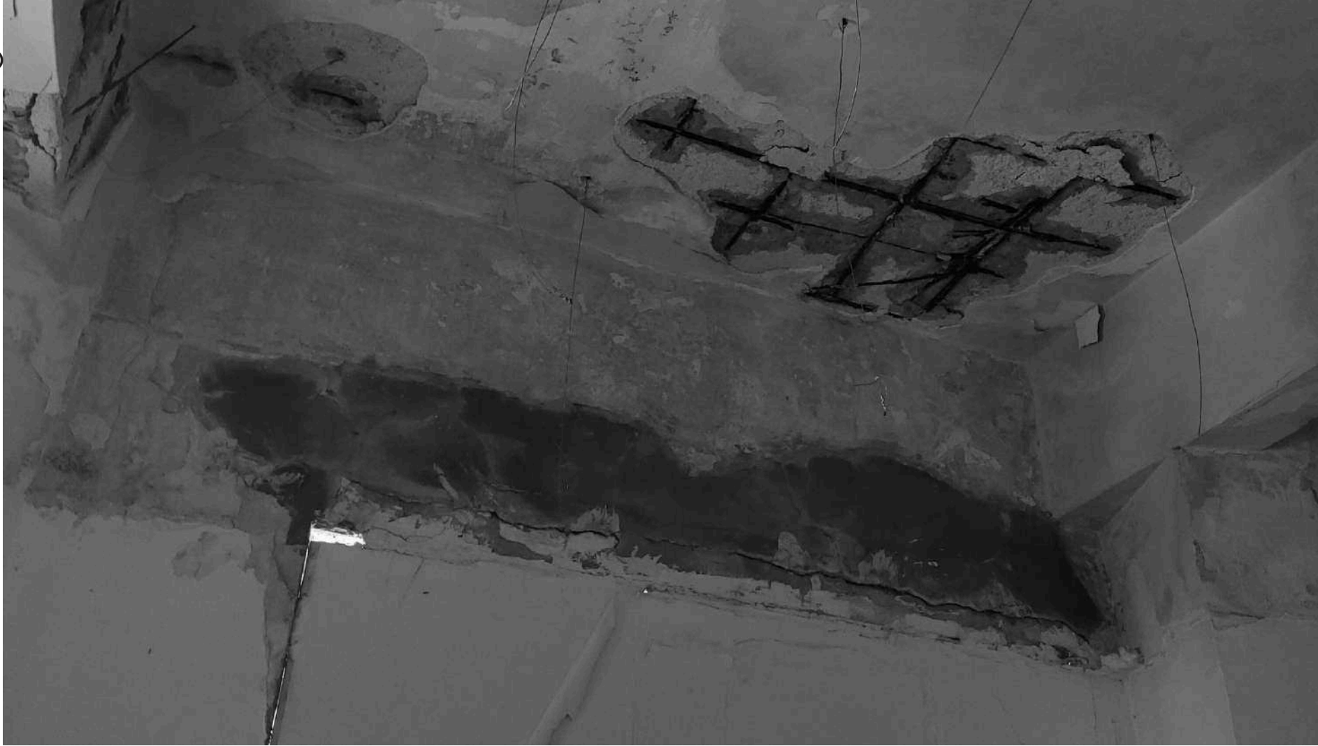
91 92 Partes da edificação com a estrutura metálica do concreto armado a mostra. Fonte: autor 2024.
