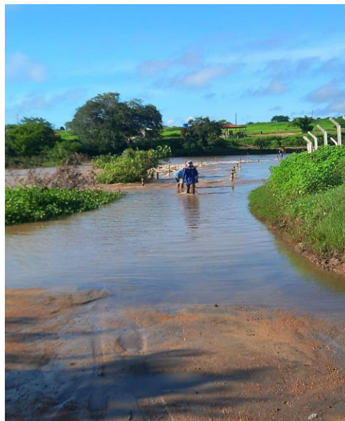
Fotografia 29: Pessoas atravessando a ponte totalmente submersa a pé
