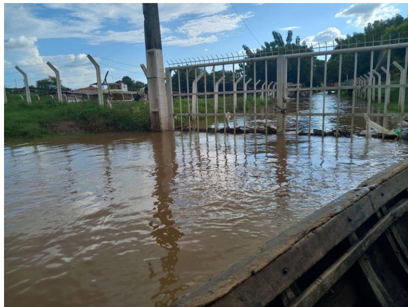
Fotografia 23: Acúmulo de lixo no Rio da Ponte
