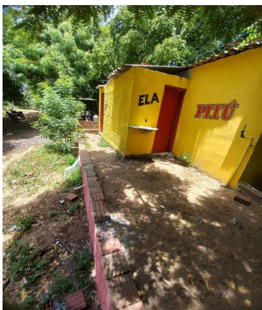
Fotografia 09: Banheiros, dentro de área expandida para comércio
