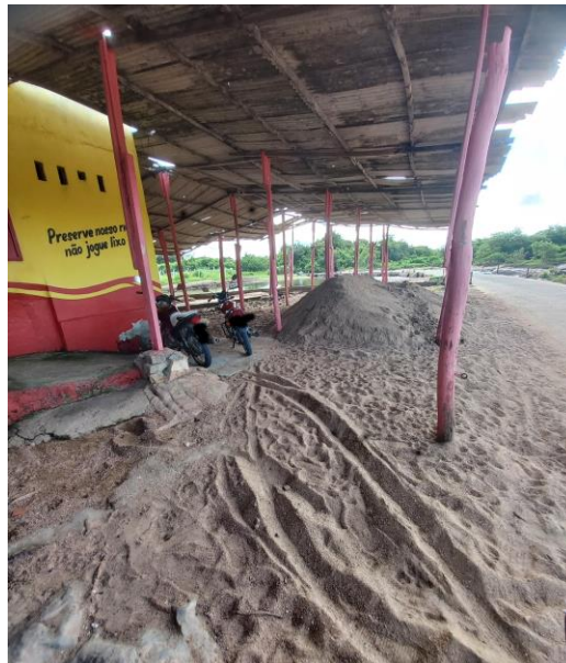
Fotografia 20: Restauração das barracas
