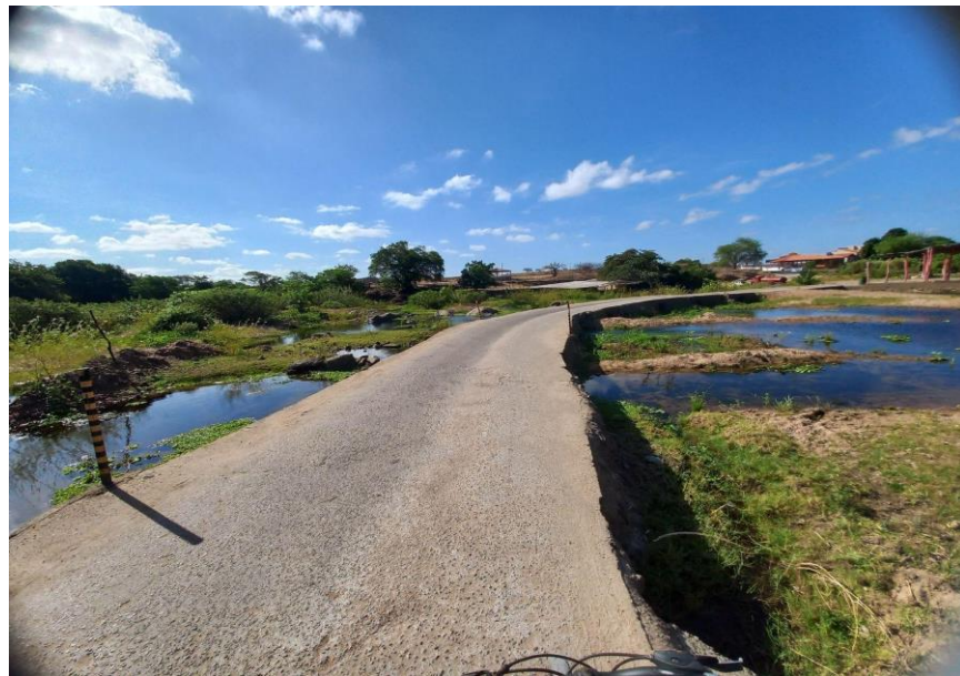
Fotografia 01: Ponte sobre o Rio Piranhas, Paulista-PB
