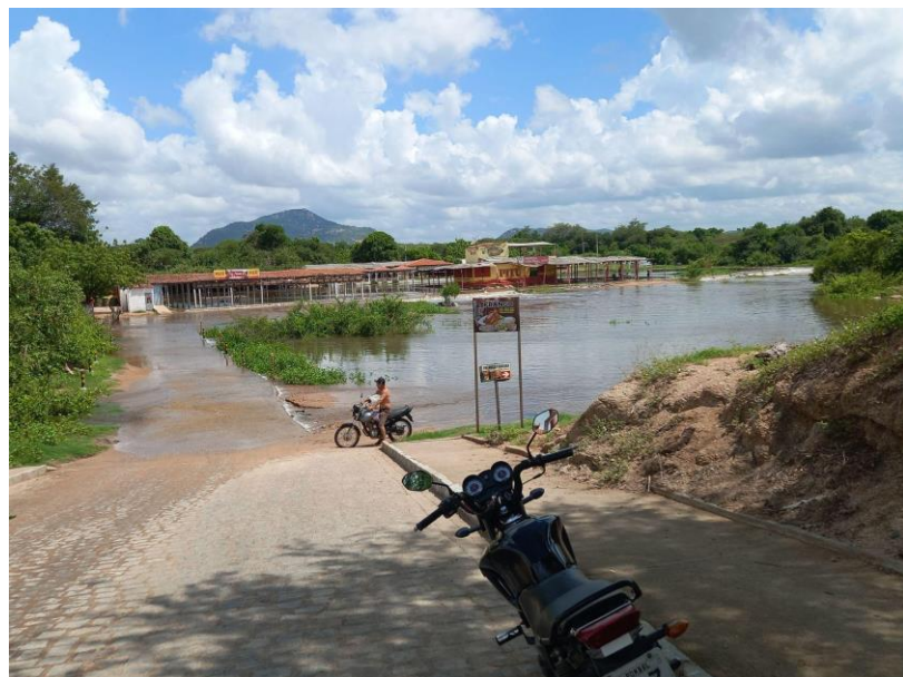
Fotografia 25: Rio da Ponte parcialmente submerso em uma cheia
