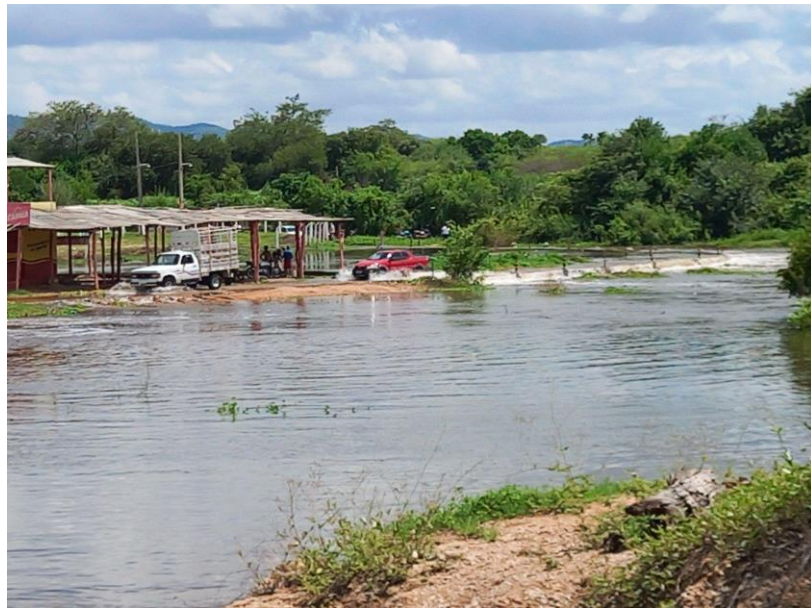
Fotografia 24: Travessia da ponte parcialmente submersa, com a ajuda de veículos
