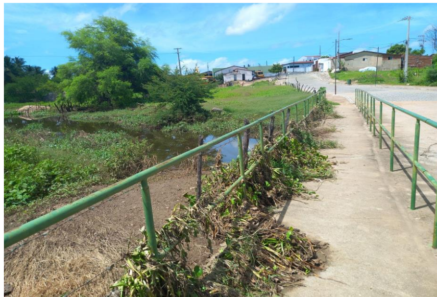
Fotografia 22: Esgoto na entrada da cidade de Paulista-PB
