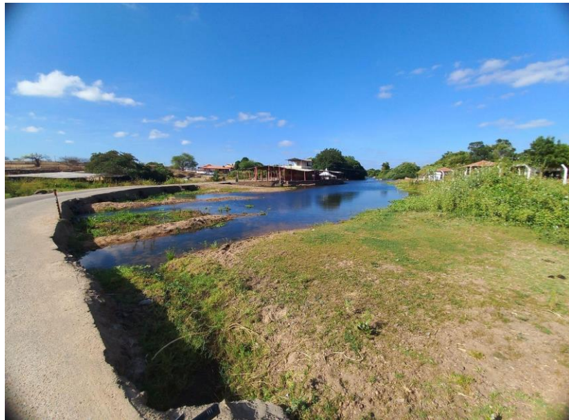
Fotografia 06: Rio da Ponte em seu estado seco
