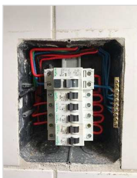
Figura 15 – Quadro de distribuição de circuitos das unidades R02, R05 e R06, respectivamente.
