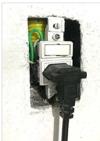
Figura 11 – Ausência de invólucros isolantes.
