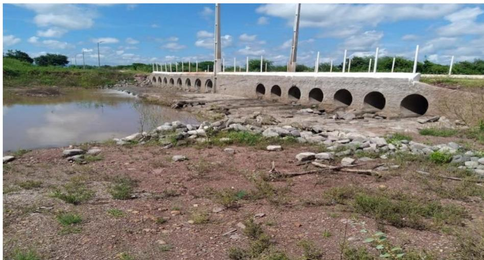
**Figura 22.** Estrada que foi construída sobre e os canais abaixo da estrada para o escoamento da água.
