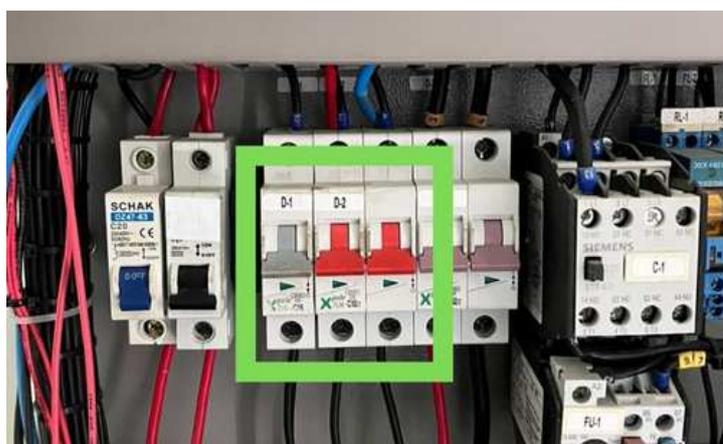
Figura 3 – Disjuntores D1 e D2
