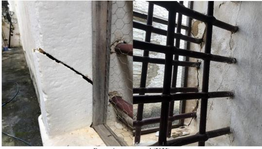
Figura 30 – Rupturas presentes nas onze janelas da edificação no encontro das barras de ferro com a alvenaria.
