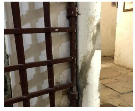
Figura 19 – Manutenção de rachaduras com uso de cimento Portland.
