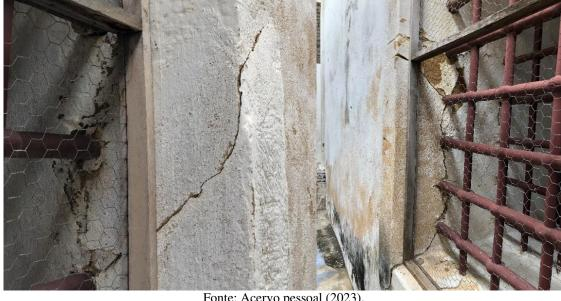
Figura 20 - Rachaduras encontradas em janelas da edificação.
