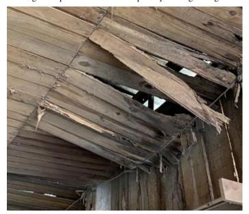
Figura 4 – Desgaste e podridão na madeira pela ação da água e agentes bióticos.
