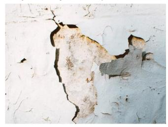
Figura 3 – Exemplo de deterioração do revestimento.
