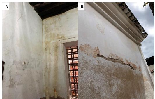
Figura 16 – A- Bolor e fissuras em áreas internas; B- Desagregação do revestimento externo e perdas de telhas.
