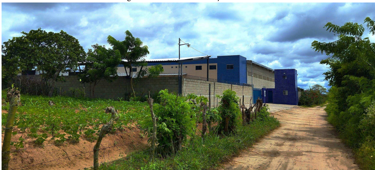
Figura 8: Centro de Distribuição da LAU
