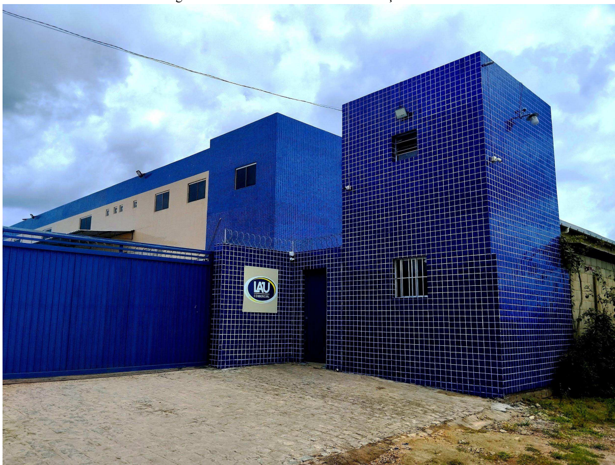
Figura 9: Fachada do Centro de Distribuição da LAU
