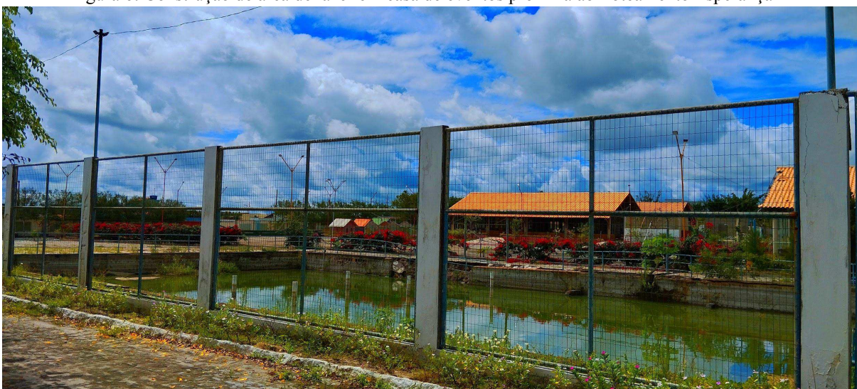
Figura 6: Construção de área de lazer em casa de eventos próxima ao Loteamento Esperança II
