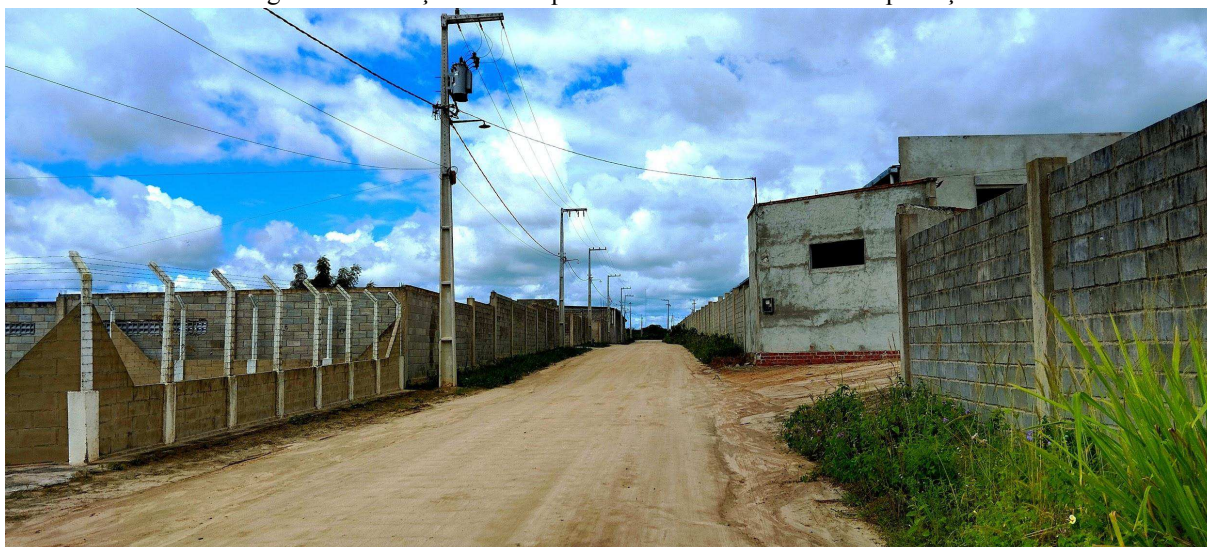
Figura 7: Instalações de complexo fabril na zona rural de Esperança
