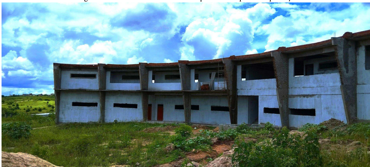
Figura 11: Parte de obra da Vila Olímpica Municipal de Esperança
