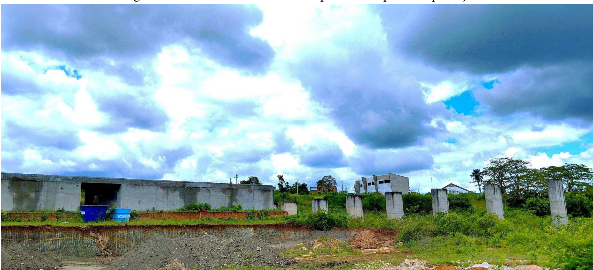
Figura 14: Parte de obra da Vila Olímpica Municipal de Esperança
