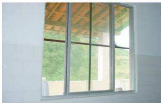
Janela de vidro com base de alumínio e com tela protetora externa
