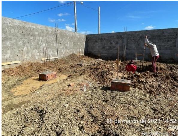
**Figura 37 - Alvenaria de embasamento**
