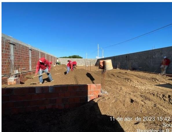
**Figura 39 - Fôrma e concretagem de vigas baldrame**
