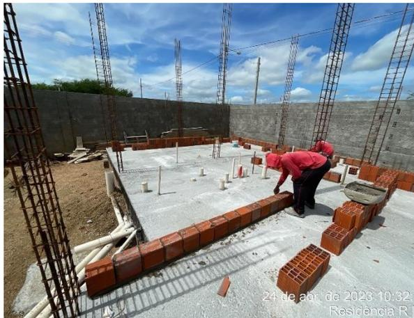
**Figura 56 - Elevação de alvenaria de vedação**
