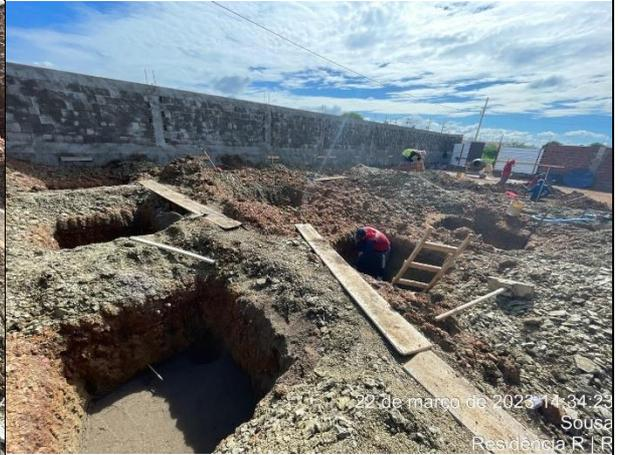
**Figura 34 - Fôrma de sapatas**
