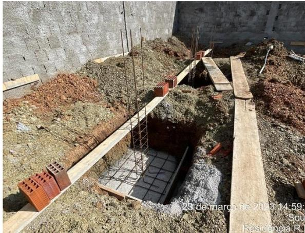
**Figura 35 - Concretagem de sapatas**
