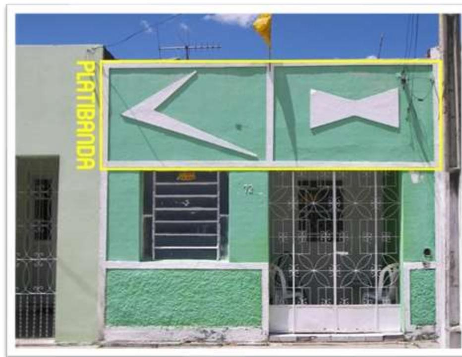
Figura 3 - Estrutura platibanda - Foto: Bahia.ws
