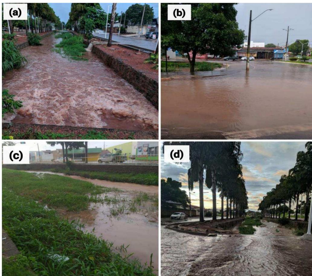
Figura 4. (a) Canal sem manutenção periódica; (b) Transbordamento do canal; (c) Canal sem manutenção periódica; (d) Alagamento da via.
