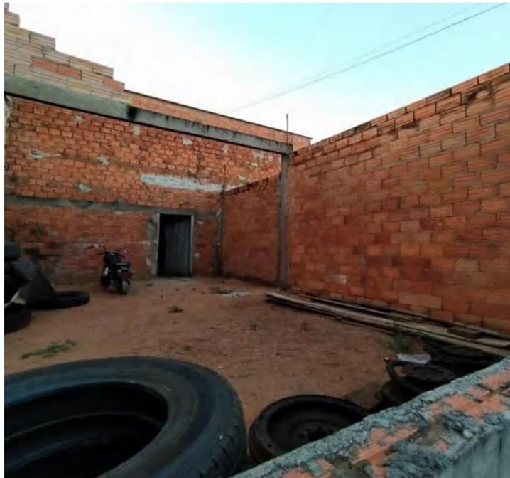
Figura 3. Execução parcial da alvenaria na sala de estar.
