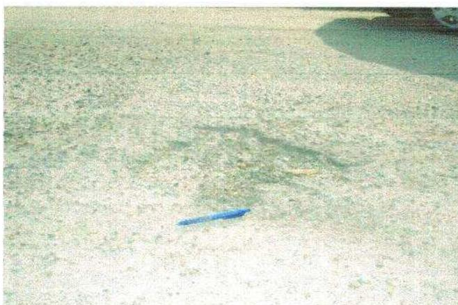
**Figura 2.10 - Desagregação no revestimento**
