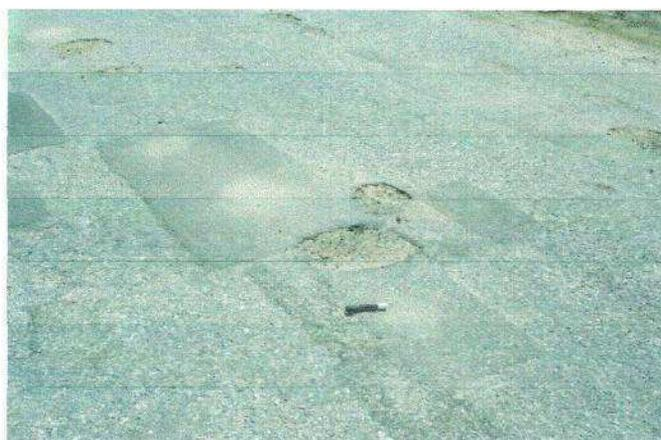
**Figura 2.9 - Painelas no revestimento**
