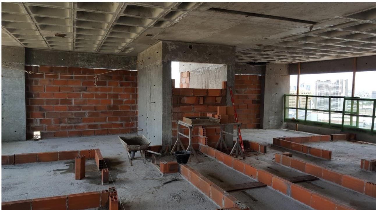
**FIGURA 1- Vedação externa e marcação de alvenaria com blocos cerâmicos.**
