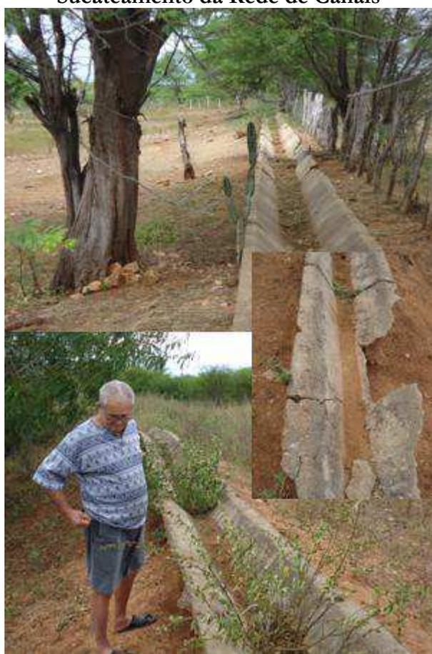
Fotos: **31** – Canal Quebrado; **32** – Irrigante olhando canal quebrado; **33** – Detalhe do canal quebrado; Autor: Ricardo Mendonça, 2008.
