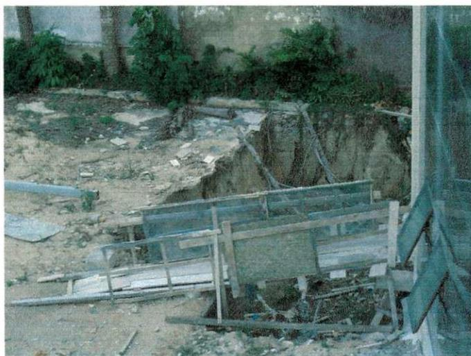
Figura 7: Corte para garagem subterrânea e caixa d'água
