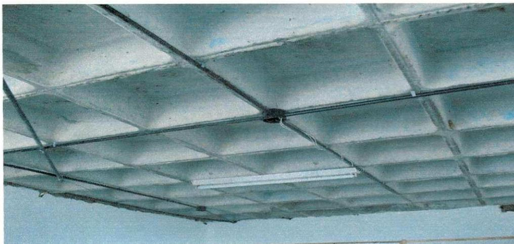
Figura 14: Laje nervuradas
