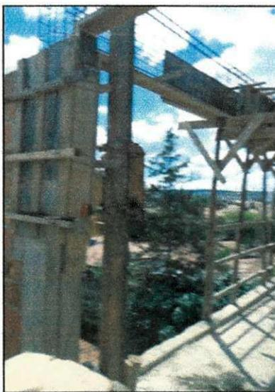
Figura 74 – Escoramento e fôrma de viga.
