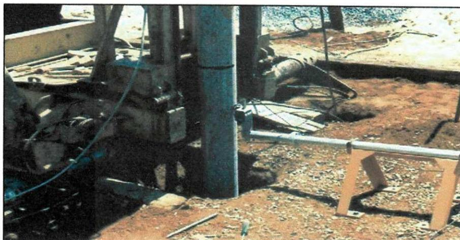
Figura 17 – Cravação de estaca pré-moldada (Fonte: Google imagens).
