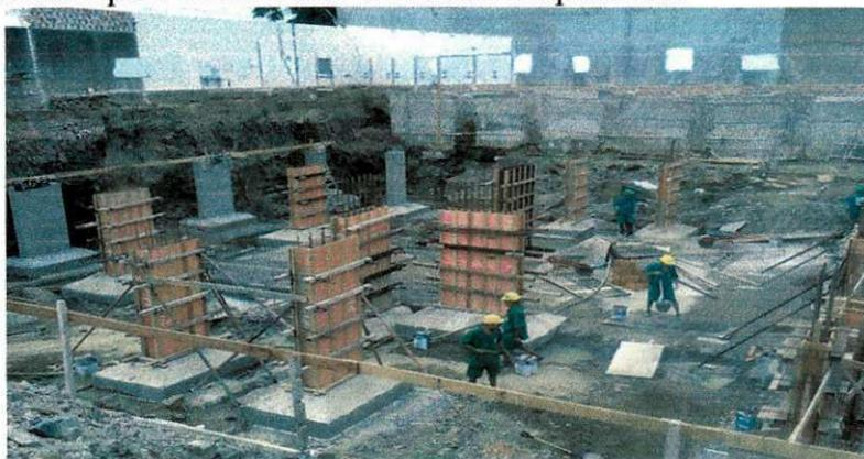
Figura 75 – Pilar com fôrma, deixando traspasse de ligação.
