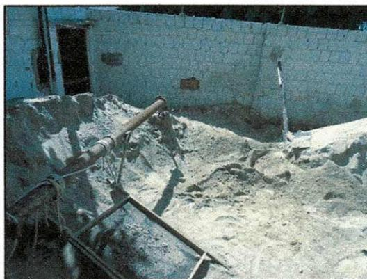
Figura 84 – Armazenamento da areia, separados em peneirados e não peneirados.
